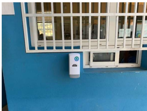
Une borne de gel hydroalcoolique installée sur le mur de la loge à l'entrée du collège
